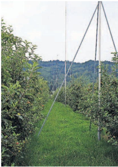
Im Obstgarten stehen die Bauprofile für die neue Überbauung. DM
